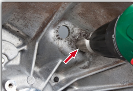
Bild 5: Löcher aufbohren
